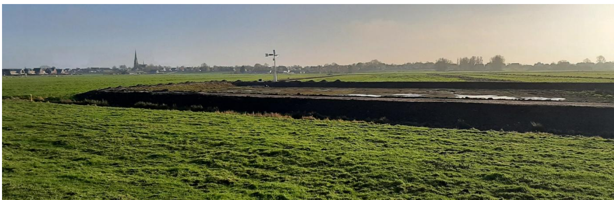
Ruygeborg 2 in aanleg
